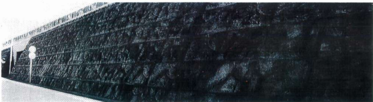
ブロック表面を着色した使用例 [エコシート法を用いた場合]
