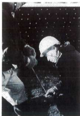
③KCパネル固定ナットの取付け
