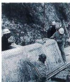
②1段目据付状況
