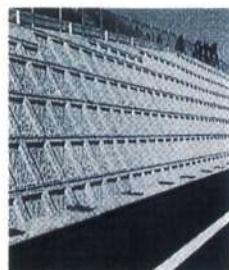
⑤施工完了
