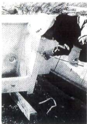
①セパレータの取付け
