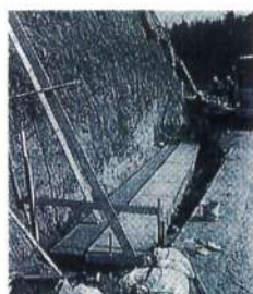
①基礎施工完了
