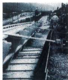
④胴込・裏込コンクリート工
